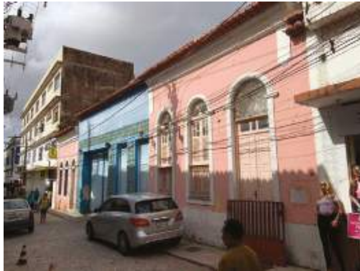
Vista externa do imóvel – imóvel a esquerda (Rua das Flores)
