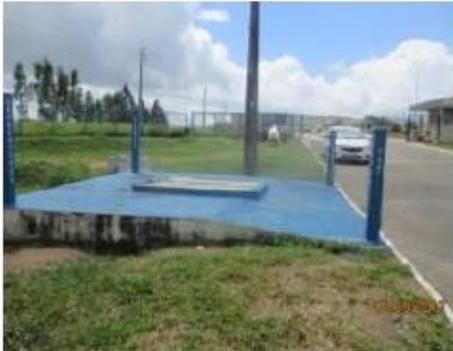
POÇO DE INSPEÇÃO DO GASODULTO
