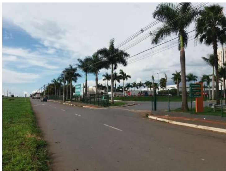
Rodovia BR-153, com o imóvel à direita
