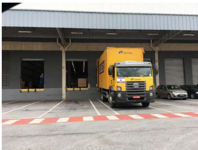
Área de galpão e marquise
