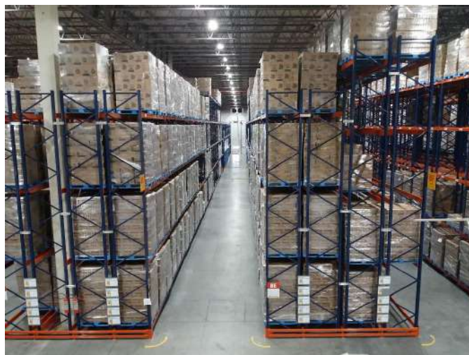
Área interna do galpão
