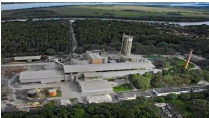
Figura 3: Planta de moagem de cimento de Nova Santa Rita
